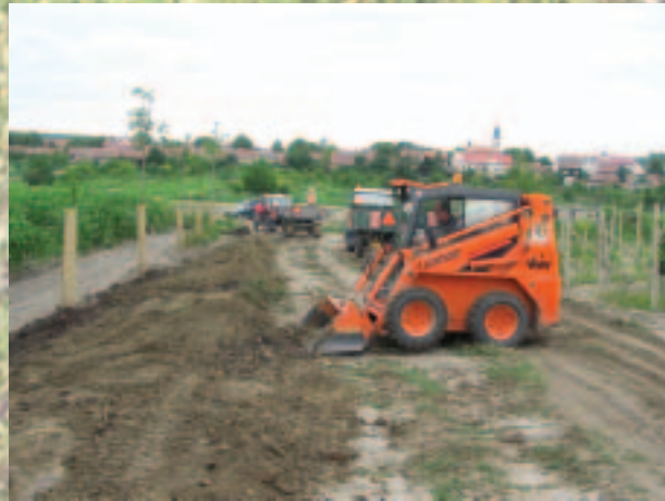
Oprava cesty po bouři.
